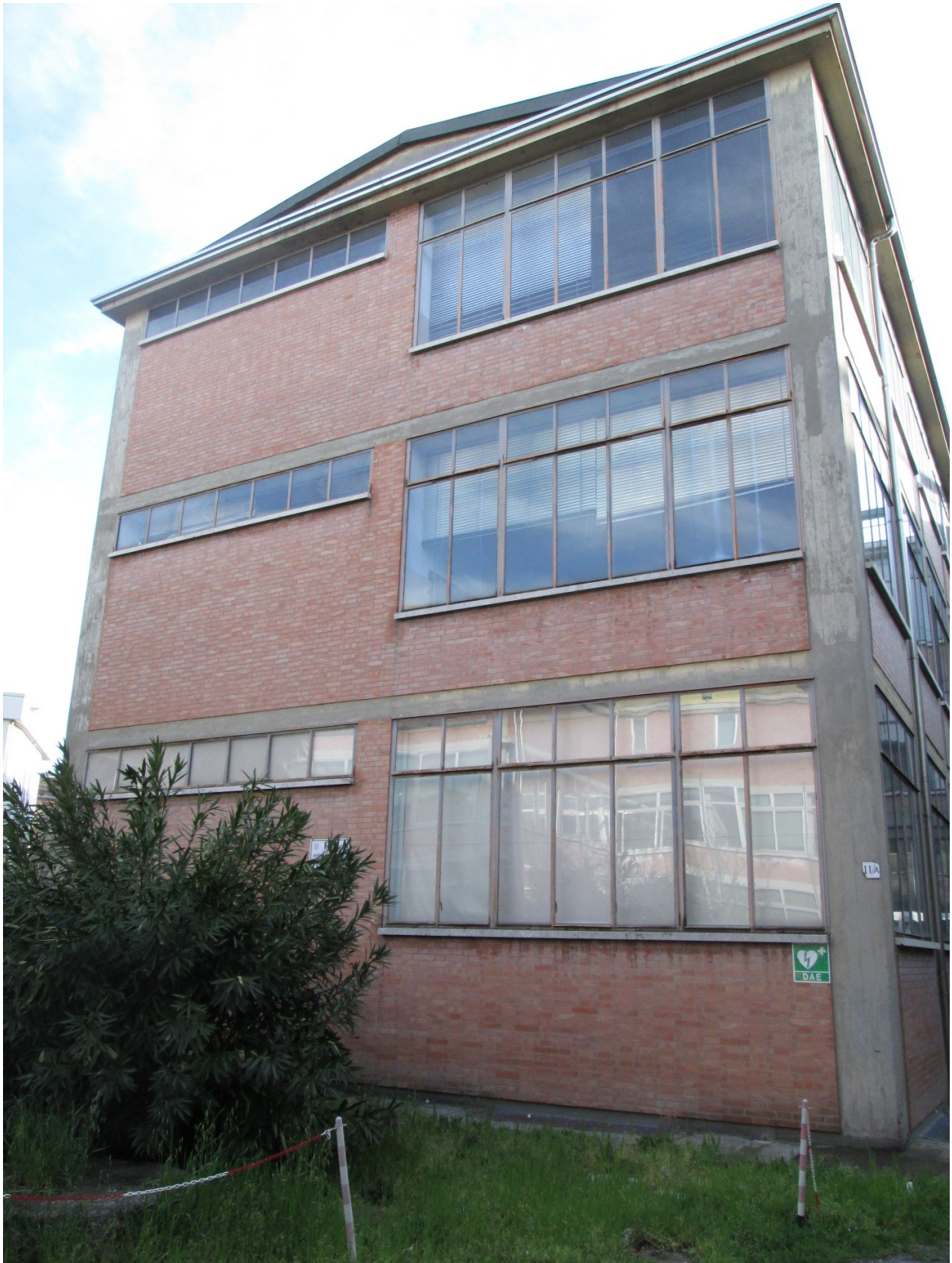
Facciata sud-ovest del blocco A
