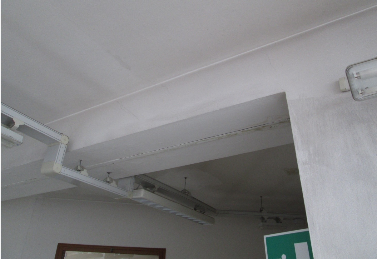
Giunto tra blocchi A e B
