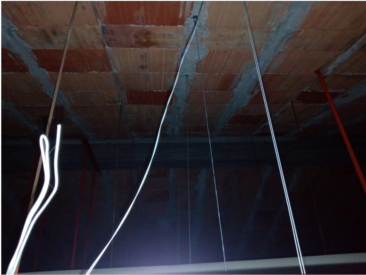
Palestra, intradosso della copertura
